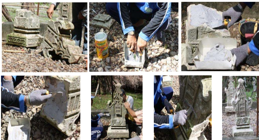
Foto 7. Proses penyambungan tanpa angkur
